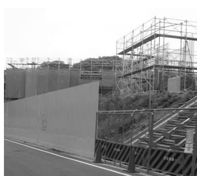
建設が進む 草花地区の市営住宅
